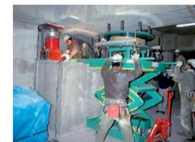
柱を切断し、免震装置を挿入
