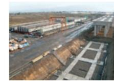
このヤードにて24本のPC桁の製作を行っています。ヤード周囲には側溝を設け、汚濁水が水田に流出することを防止し、生コン洗い場には、PH処理装置を設置しています。
