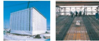
冬の寒冷地対策として養生シートによる封緘設備、温風ヒーターによる給熱養生、小型温度記録計を用いた温度測定管理を実施しています。
