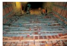
流動性の高いコンクリートに対応し、箱桁橋では通常使用しない「ふた型枠」を設置しました。
