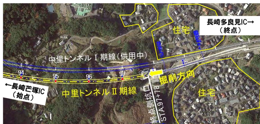
図-1 終点坑口周辺の状況
