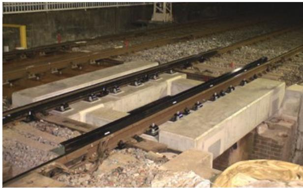
写真－ 11 宇治線第3号橋梁桁架替え
