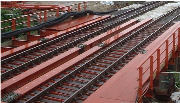
写真－1 従来工事桁（鋼製桁）
