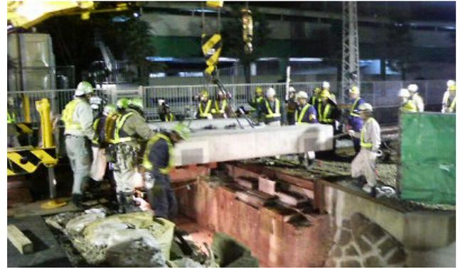
写真－ 10 宇治線第3号橋梁桁架替え
