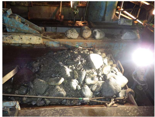
写真-4 推進時の玉石状況
