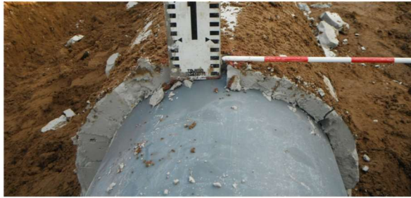
写真-3 ガイドパイプ空隙充填状況
