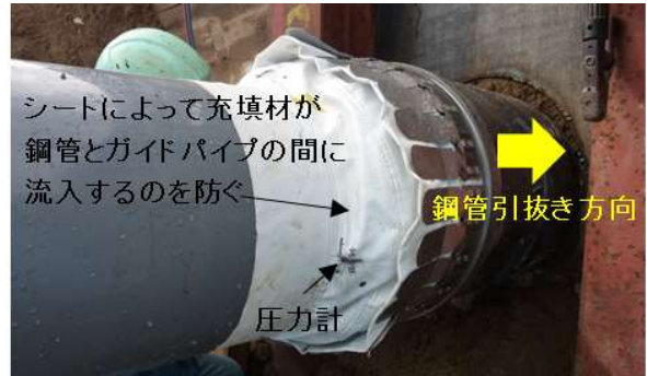
写真-1 鋼管への充填材流入防止シート
