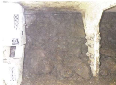
写真-5 刃口内の地山状況
