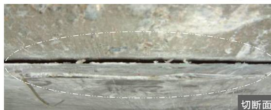
写真-5 4層施工後の切断面状況
