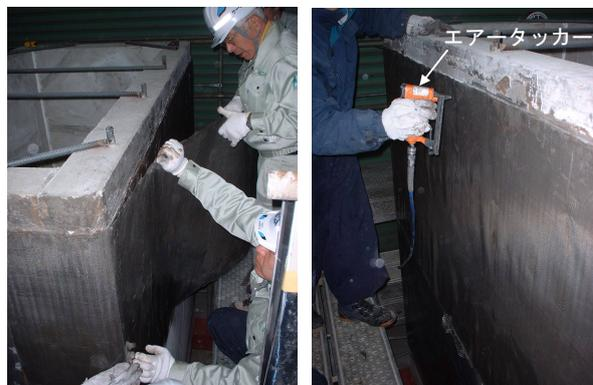
写真-3 シート貼付けおよび仮止め状況
