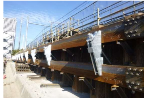
写真-2 PC鋼より線定着【浦和工区】
