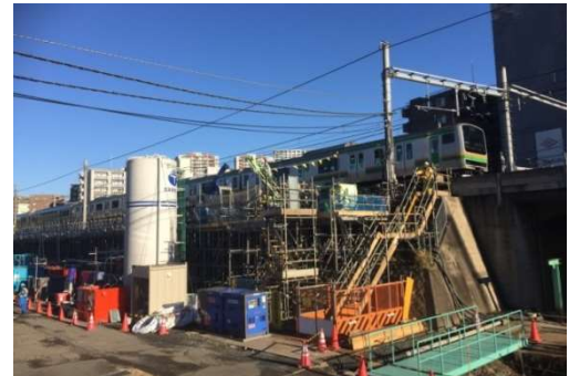
写真-3 アンカー施工状況【大宮工区】
