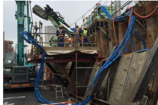
写真-1 アンカー施工状況【浦和工区】
