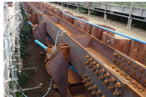
写真-4 PC鋼棒定着【大宮工区】
