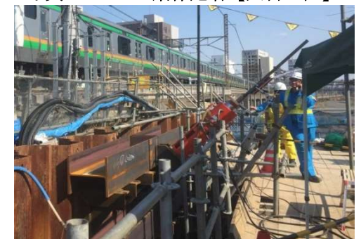
写真-5 アンカー確認試験状況
