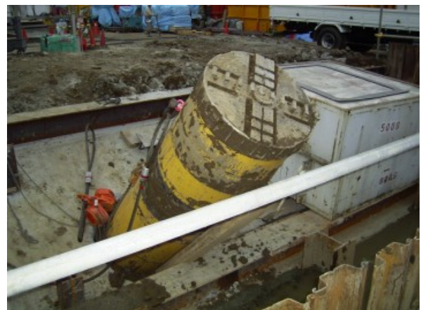
写真一5 掘進機到達状況
