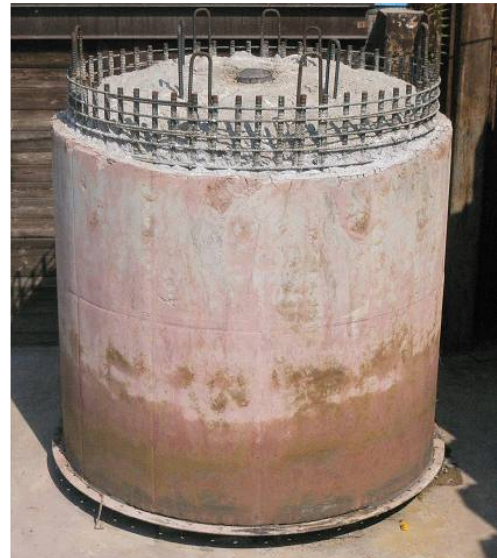
写真-4 硬化後の外観状況 (実験ケース②)
