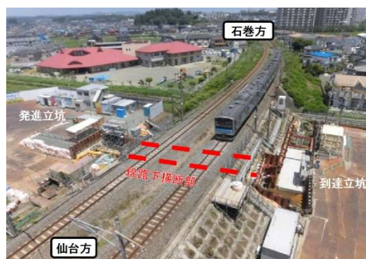
写真-1 現場全景
