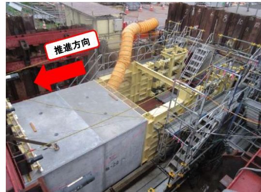
写真-2 函体掘進状況
