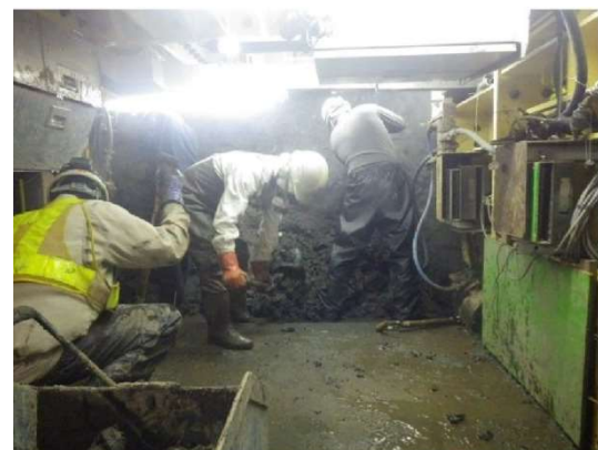
写真-3 切羽掘削状況
