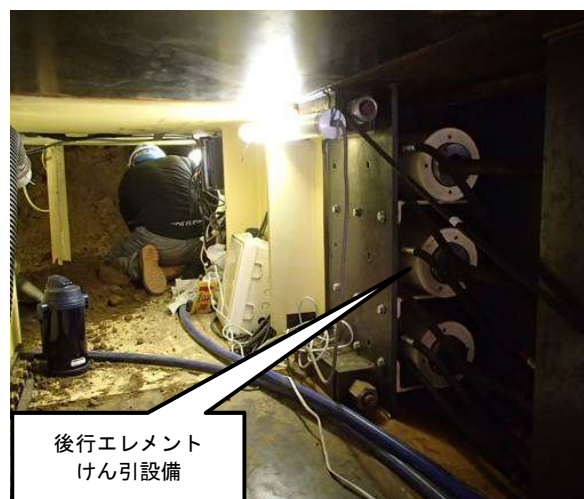
写真-3 試験状況 (エレメント内部)
