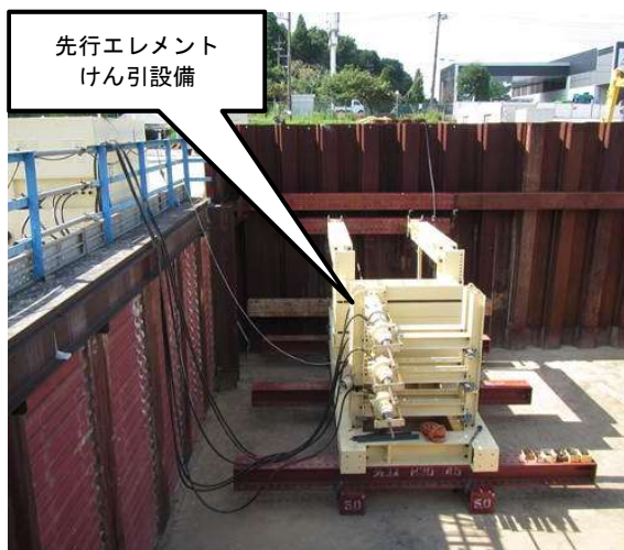
写真-2 試験状況 (到達立坑)
