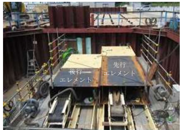
写真-1 試験状況 (発進立坑)
