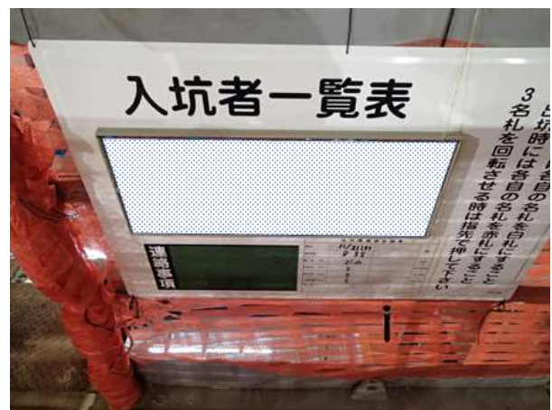
写真－2 入坑者表示の例（シールドトンネル）
