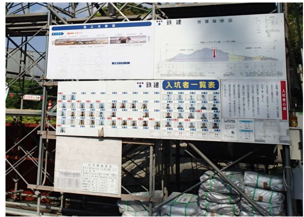
写真－1 入坑者表示の例（山岳トンネル）
