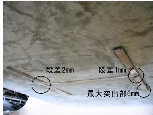
写真-10 2回目試験結果切断面
