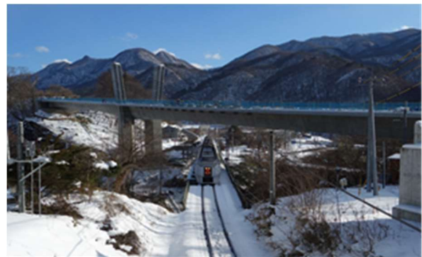
写真-2 白砂川橋全景 (平成 27 年 10 月)
