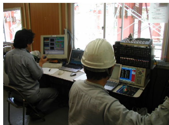
写真-1 集中制御室風景
