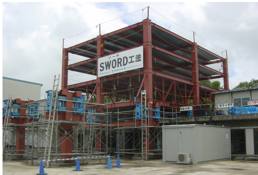
写真-2 試験体全景
