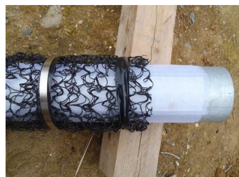
写真-3 フィルター材設置状況
