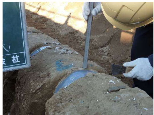
写真-11 注入材厚測定状況
