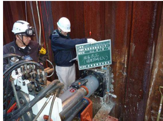
写真-8 推進同時注入状況
