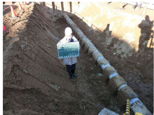
写真-10 注入材厚確認(全景)
