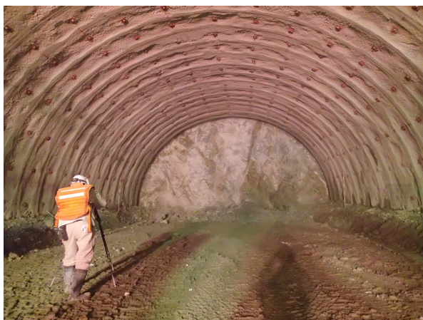
写真-1 切羽撮影状況
