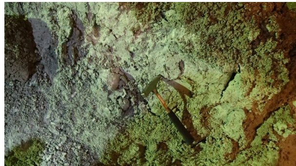
写真-3 断層粘土の状況
