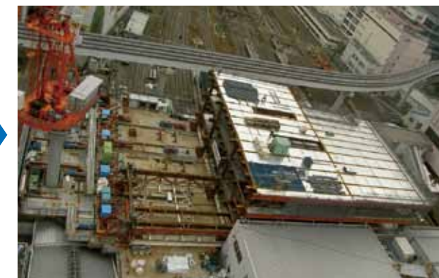
2回目スライド完了後、3回目スライド部の鉄骨建方準備中
