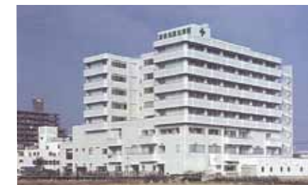
海老名厚生病院高度医療化施設
