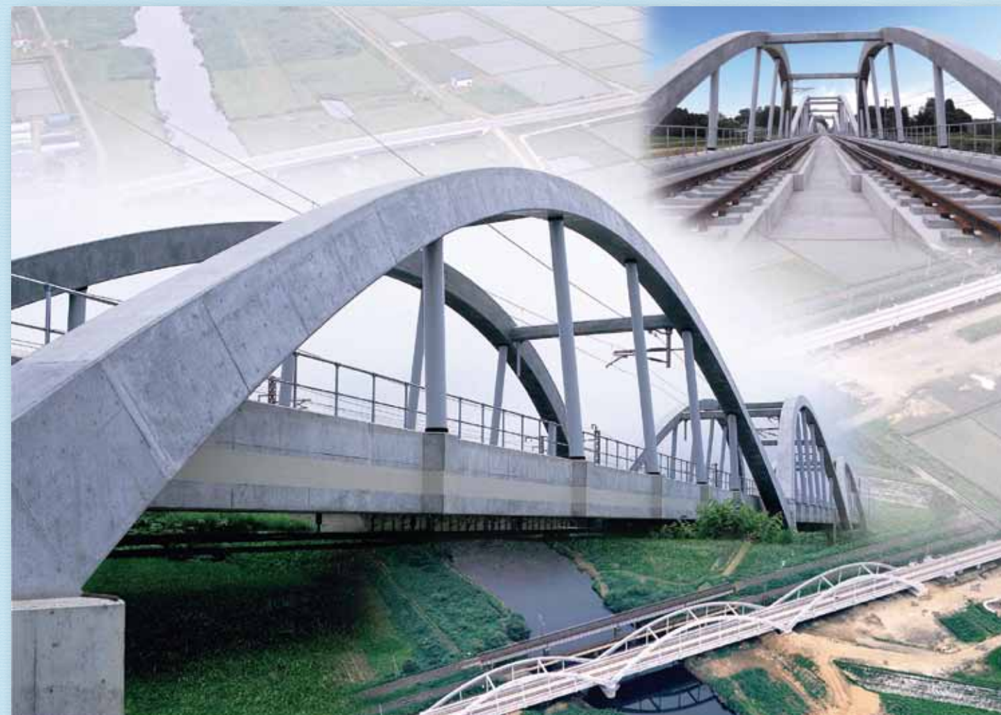
東北本線天間川橋梁（青森県）
