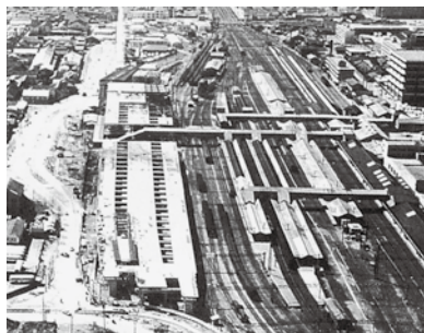
京都駅高架橋その他
