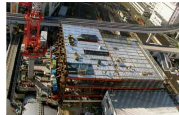
1回目スライド完了後、2回目スライド部の鉄骨建方完了
