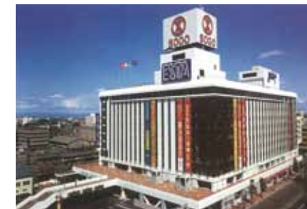
札幌ターミナルビル
