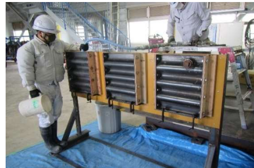
写真-6 充填状況
