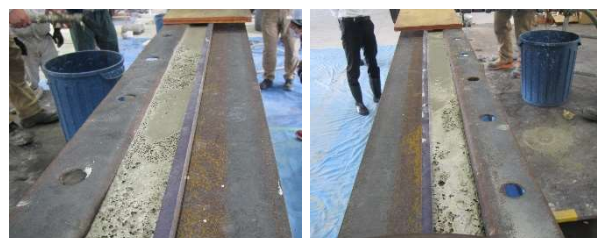
写真-8 試験体充填状況
