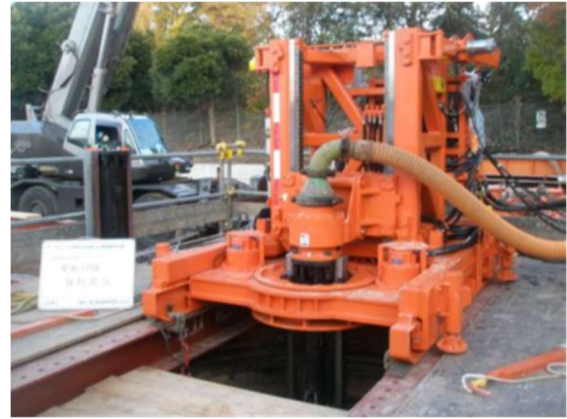
写真-5 杭打ち機セット
