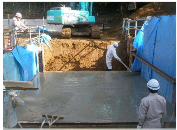
写真－1 低強度モルタル打設状況
