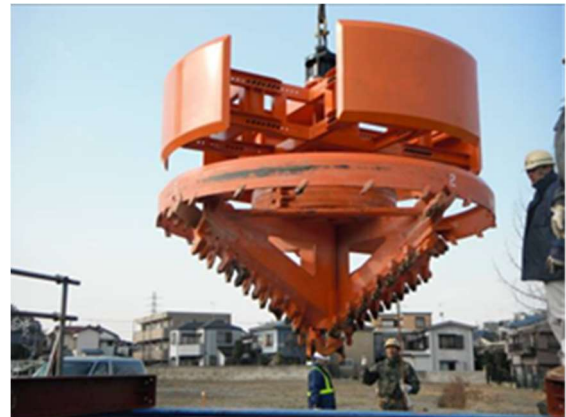
写真-11 ビットの投入状況
