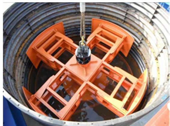
写真-12 口元管内に投入されたビット
