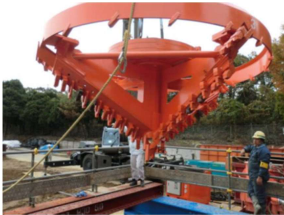
写真-3 ビット投入
