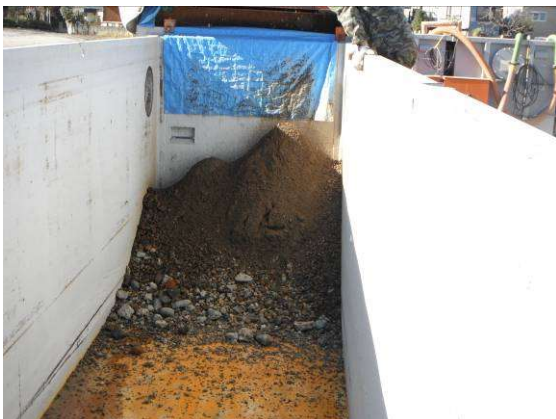
写真-14 排土状況（固結シルト）
