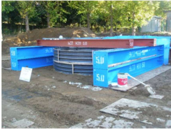
写真-2 口元管設置
