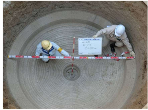
写真-6 軌跡確認1
