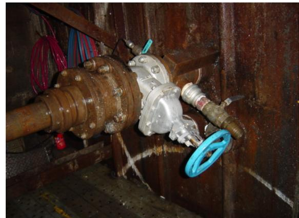
写真-2 口元装置設置状況
