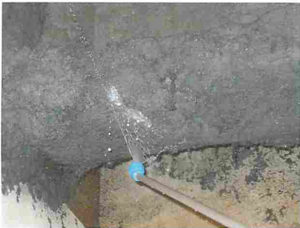
エコベスト(含浸固化剤～無機)をアスベストの厚い層すべてに含浸させます。
