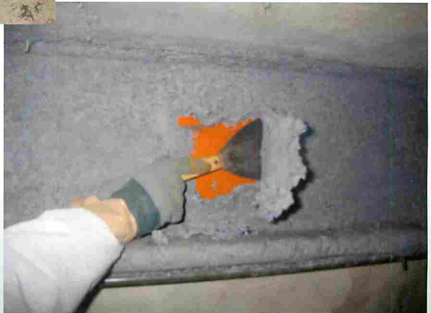
エコベスト(含浸固化剤～無機)を吹付け安全化し、完全除去します。
