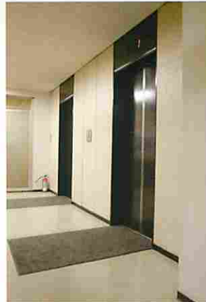
構造物の耐火・耐熱性の劣化がない
