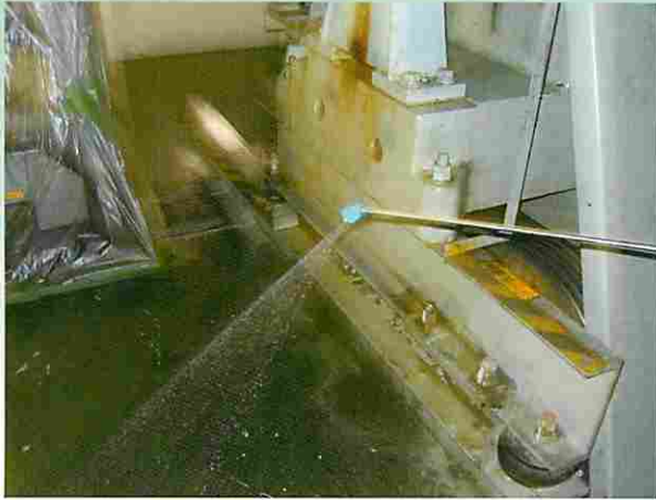
壁や床に付着しているアスベストを安全化します。
