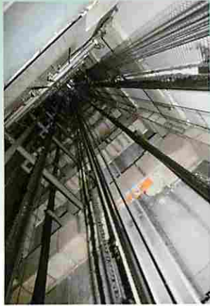
シャフト内の大掛かりな足場や養生作業は不要
