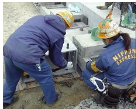
主桁セット状況
