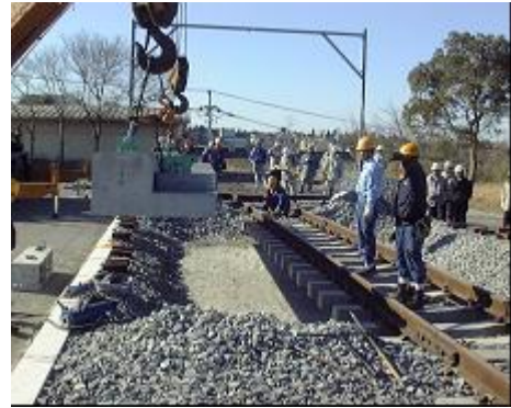
主桁つり込み状況
