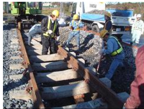
図－9 掘削試験状況
