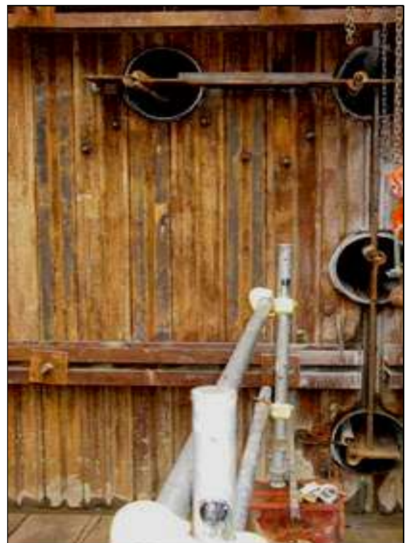
写真-5 挿入完了
