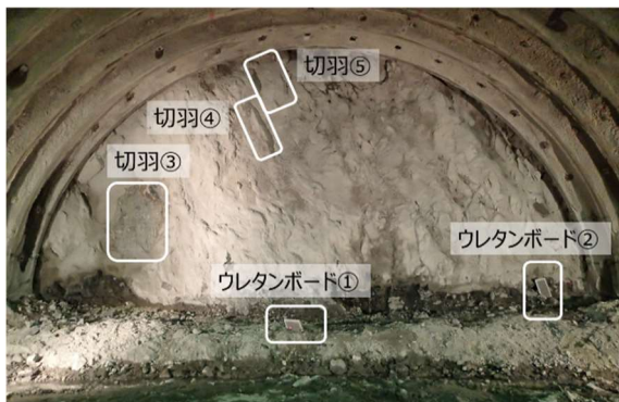
写真-1 ウレタンボード及び切羽測定位置
