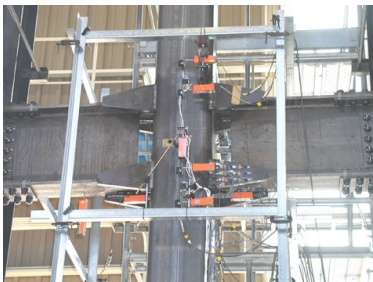
写真－2 No.3 試験体接合部
