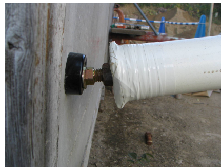
写真－７ 脱落防止機構
