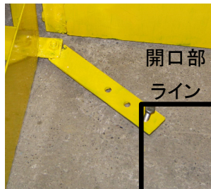
写真－４ ズレ止め機構
