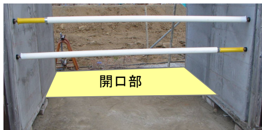
写真－５ FRP単管つつぱり棒
