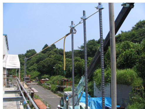
写真－９ 親綱固定金具使用状況
