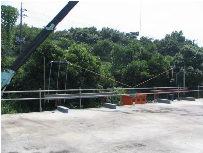
写真－10 載荷試験状況（静的荷重）
