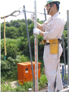
写真－11 鉄筋変形測定状況
