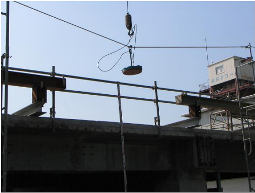
写真－12 載荷試験状況（動的荷重）
