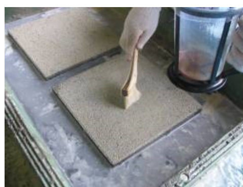
写真－２ 湿潤対応プライマー塗布状況
