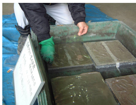
写真－３ タフシート貼付け状況
