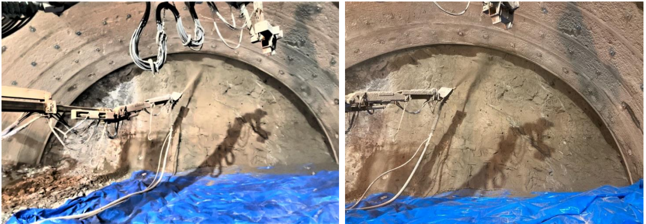
写真-2 天端部一次吹付けにおけるはね返り率測定状況
