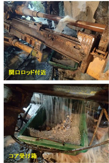
写真-6 現地試験状況
