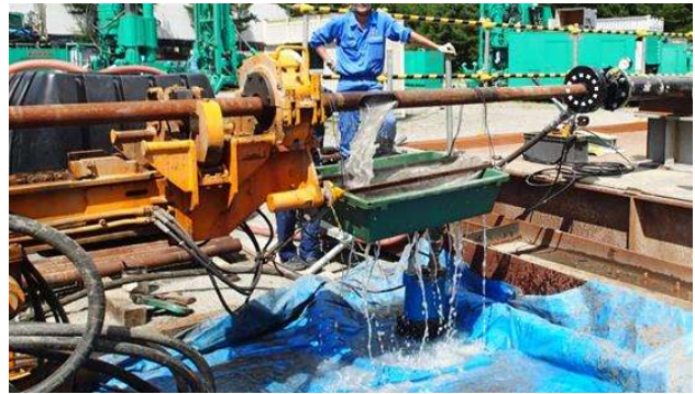
写真-3 PS-SR 工法試験状況
