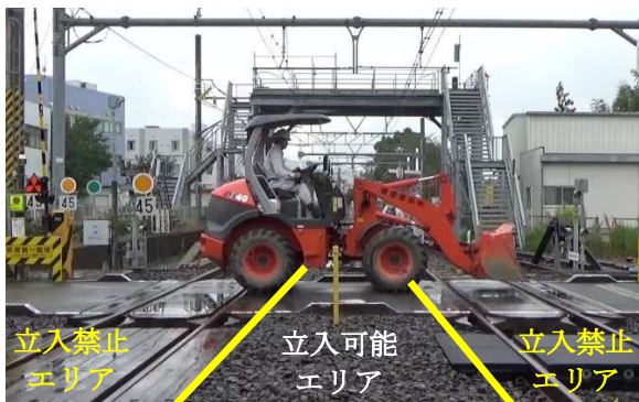
図-6 重機・車両の侵入検知試験状況
