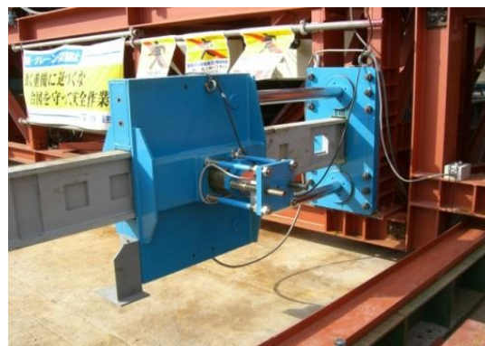
写真-1 ソード工法の推進装置概要
