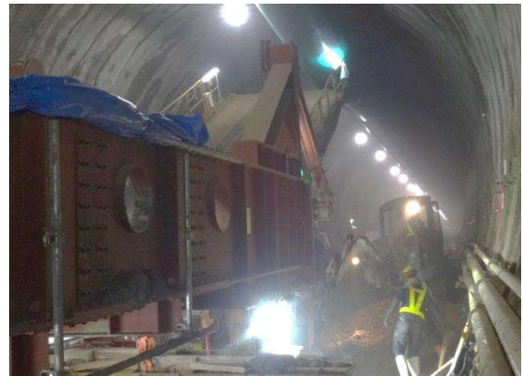
写真-1 跳上げ式インバート栈橋 (掘削状況)
