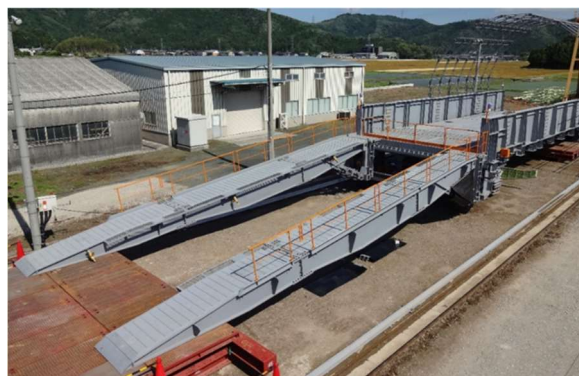
写真-3 切羽側斜路 (分割時)
