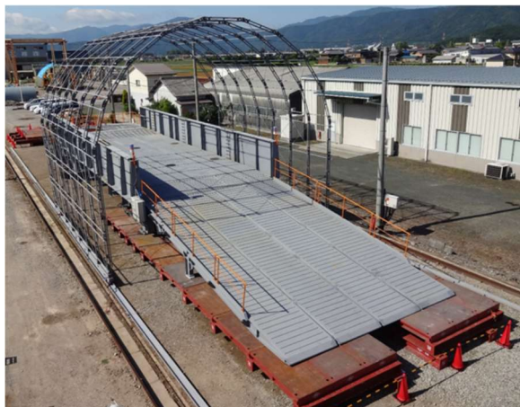
写真-2 作業ステージ, 坑口側斜路
