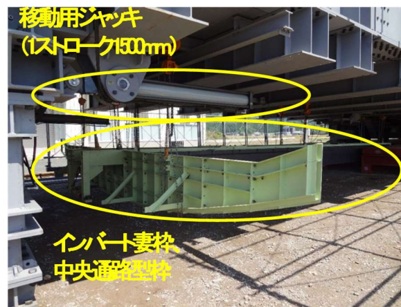
写真-4 妻枠, 中央通路型枠
