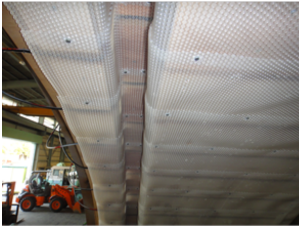
写真-2 防水シート
