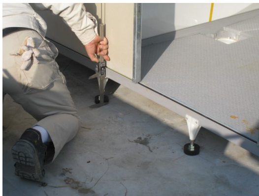
写真-4 沈み込み量計測状況
