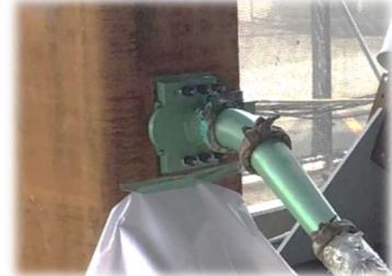
鋼管充填コンクリート
