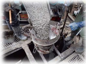
場所打ちコンクリート杭
