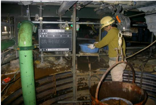
写真-3 ホーム下での深礎工法
