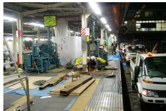
写真-2 夜間線路閉鎖間合いの施工
