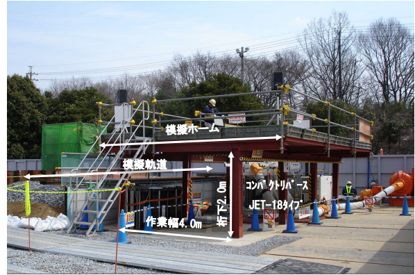
写真-5 施工試験状況
