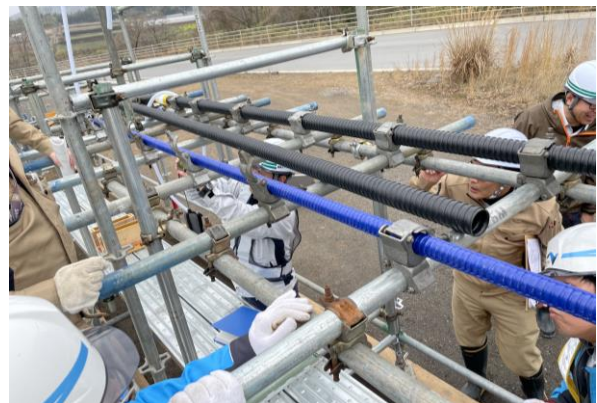
写真-4 PC鋼材健全性確認
