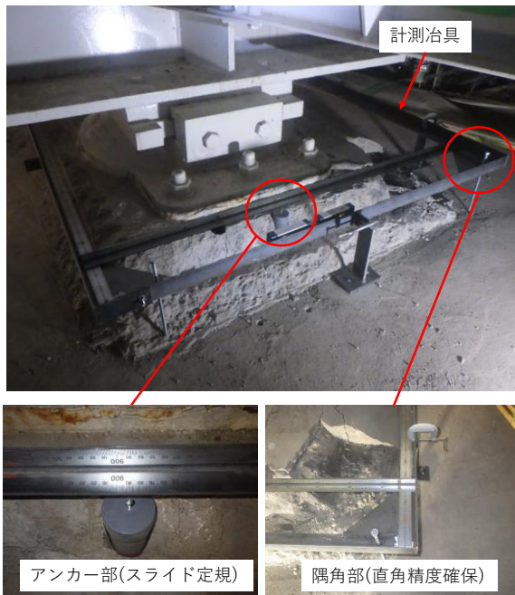
写真-1 計測治具の設置状況
