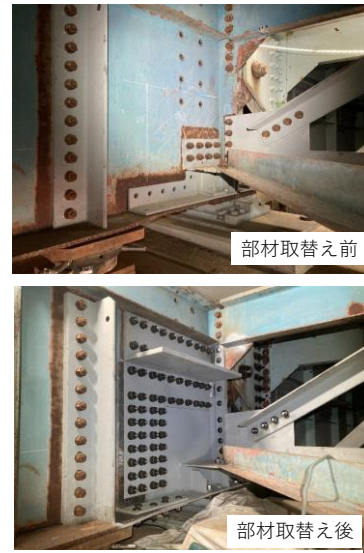
写真-3 部材取替部全景
