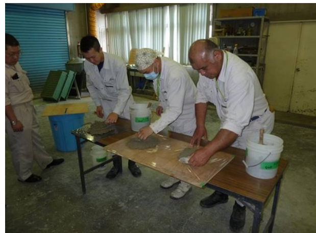
写真-4 敷き均し状況
