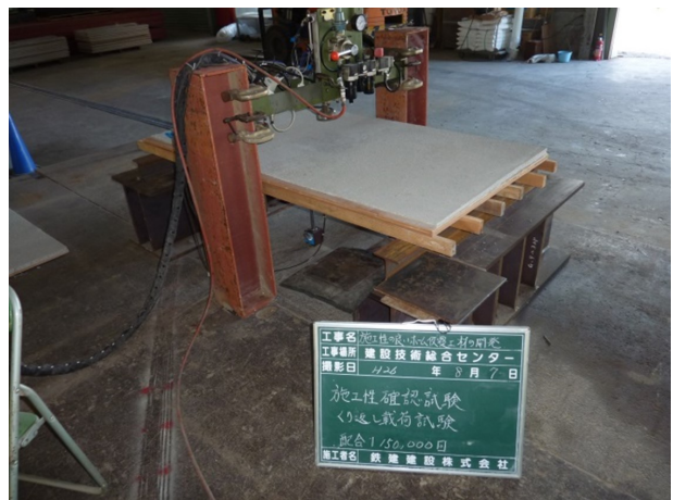
写真-13 繰り返し載荷試験完了
