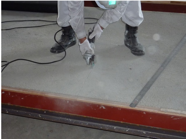
写真-10 試験体切断状況
