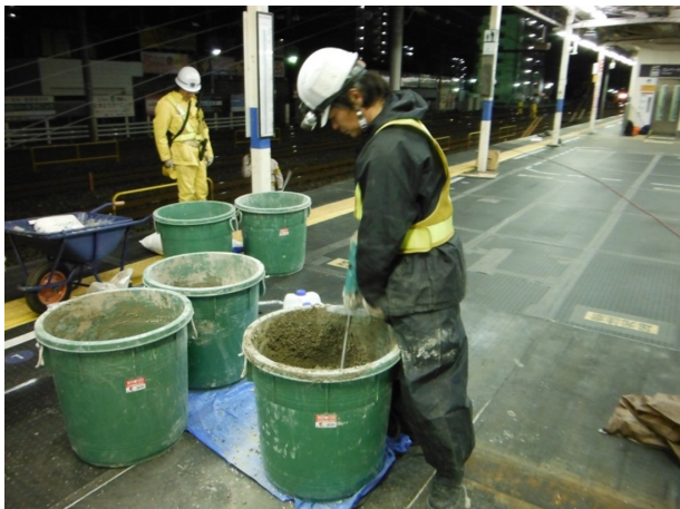
写真-17 練り混ぜ状況 (ホーム上)
