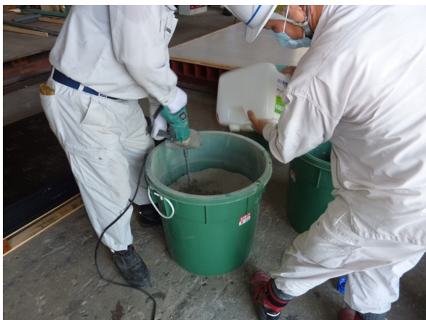
写真－8 練り混ぜ状況
