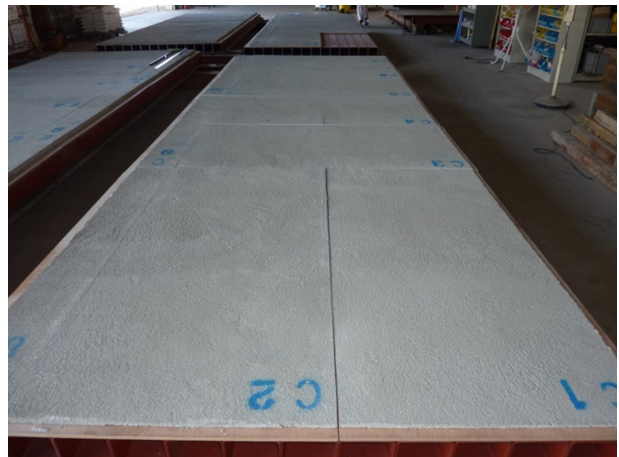
写真-14 転用再設置完了
