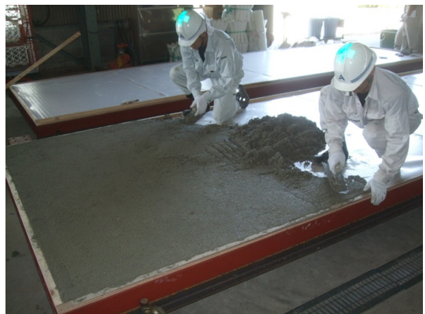
写真－9 敷き均し状況
