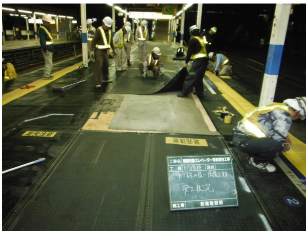
写真-16 ゴムマット敷設状況
