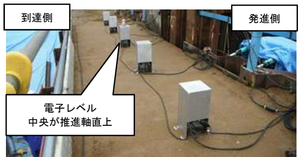
写真-2 地表面計測状況
