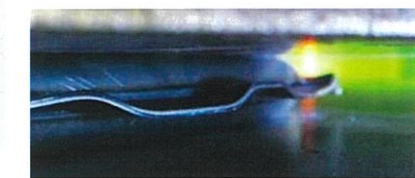
写真.4 超薄板ジャッキのモルタルグラウト加圧充填状況
