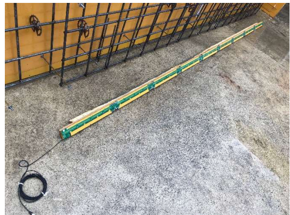
写真-4 センサ No.2 設置状況
