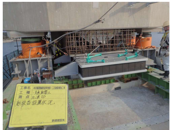
写真-3 免震支承部設置状況
