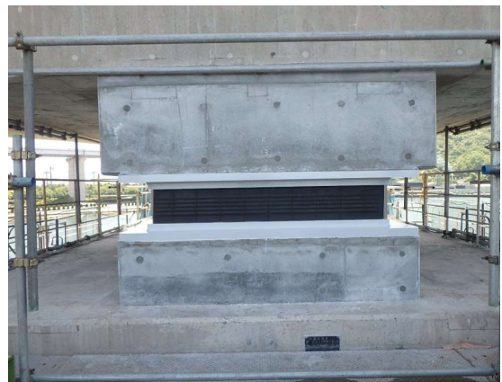
写真-4 免震支承交換状況（海上橋脚）
