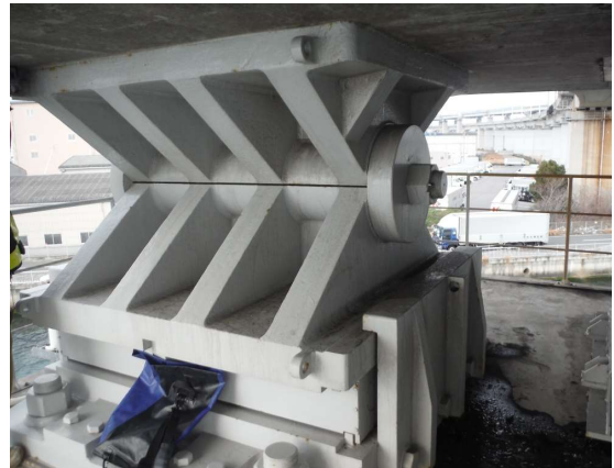
写真-1 既設支承（海上橋脚）
