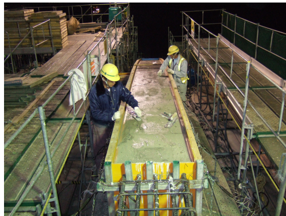
写真-3 アーチリブ仕上げ作業状況
