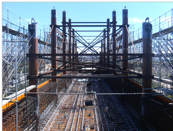
写真－1 鉛直材設置状況
