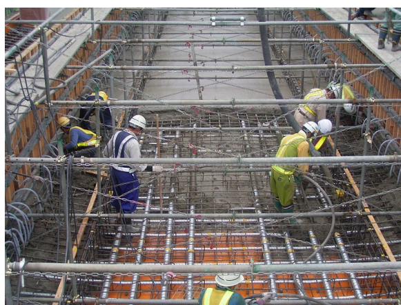
写真－2 補剛桁コンクリート打設状況
