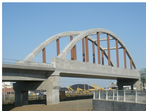
写真-4 完成写真
