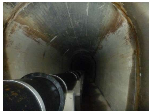
写真-2 水路トンネル内の状況
