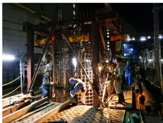
写真-2 場所打ち杭鉄筋かご建込み作業 (4台同調)
