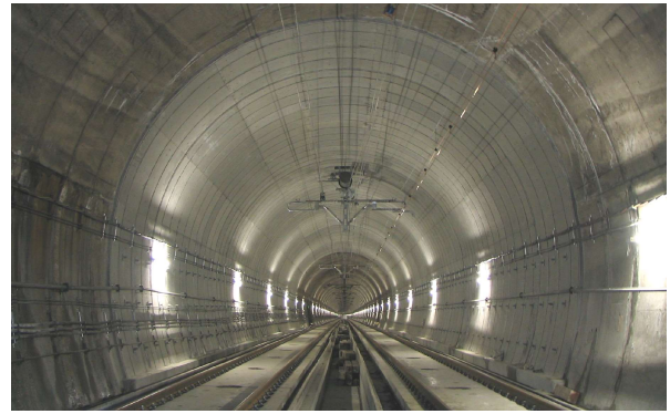
写真-2 内巻区間(施工後)
