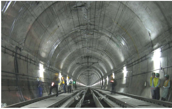
写真-1 内巻区間(施工前)
