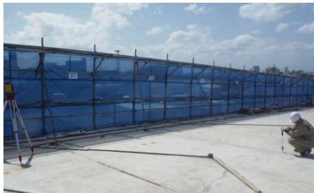
写真-4 橋面計測状況
