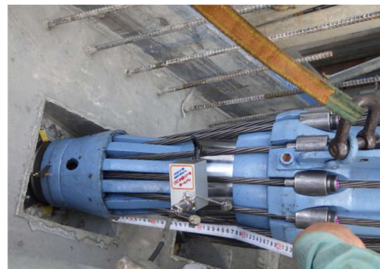
写真-2 変位計取付状況(緊張側)
