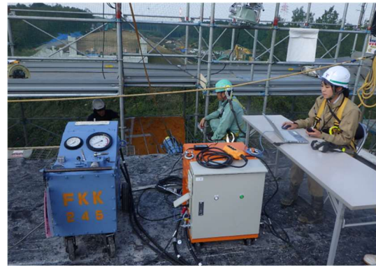
写真-1 自動緊張施工状況
