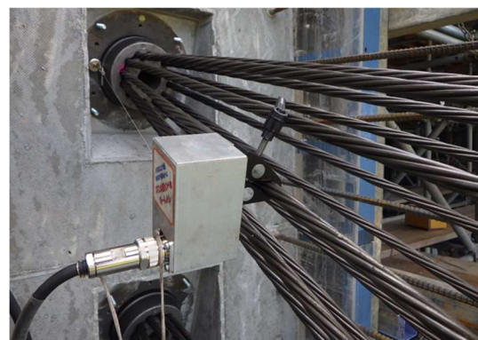
写真-3 変位計取付状況(固定側)
