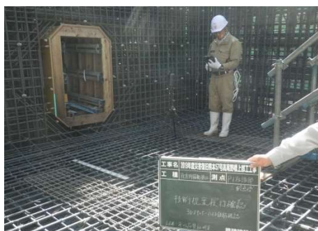
写真-5 鉄筋計測状況
