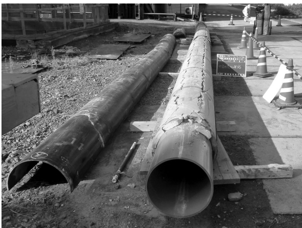
写真-7 中詰め充填状況確認
