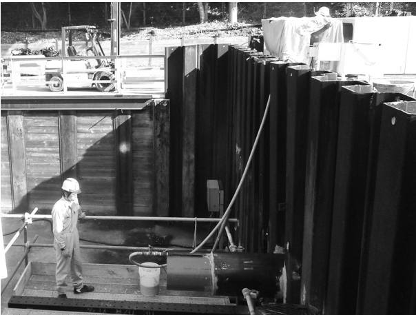
写真-4 中詰め・裏込め注入状況
