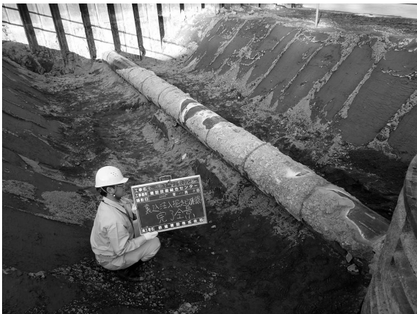
写真-5 充填状況掘出し確認全景(右側)
