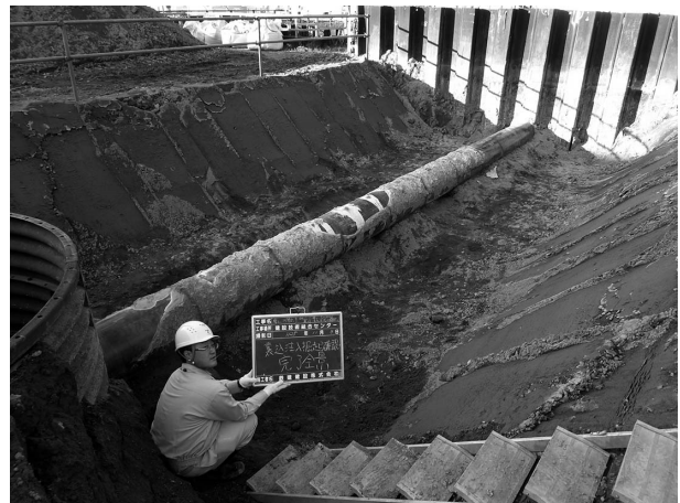
写真-6 充填状況掘出し確認全景(左側)
