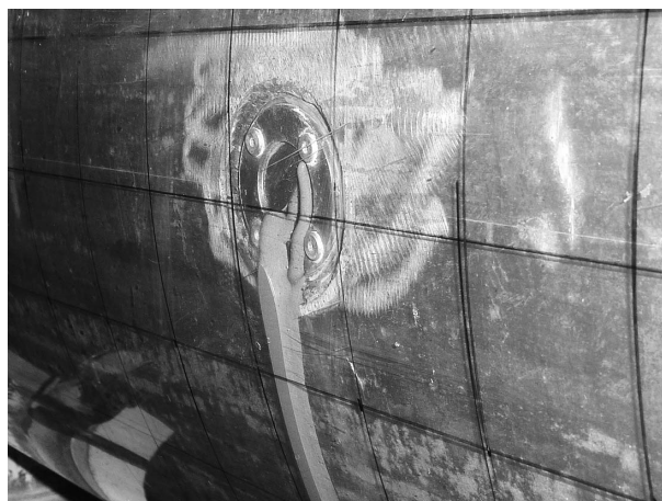
写真-1 注入材吐出状況
